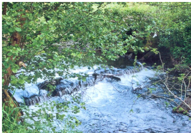
Reste der Schleusenanlage
