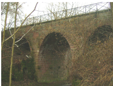
Sandsteinviadukt Lückgarte Fertigstellung: 1876
