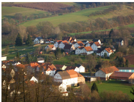
Bild oben: Baugebiet „Auf dem Stein“
